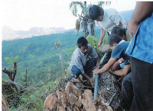
水道管の修理。バギア村の水道は山奥から1本の管で引かれている。
