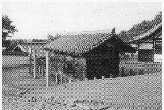
写真2-② 関伽井屋側面 （參籠宿所右側・仏餉屋左側）
