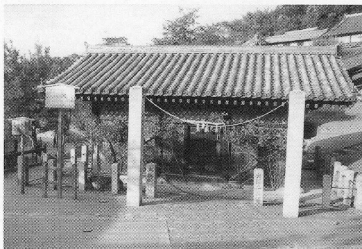
写真2-① 二月堂関伽井屋若狭井 四周を柵で囲み結界（関伽井屋飾り）
