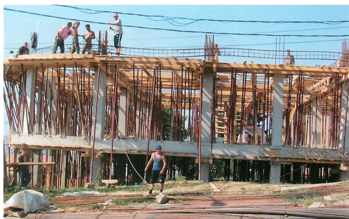
民家の建築作業の様子。
