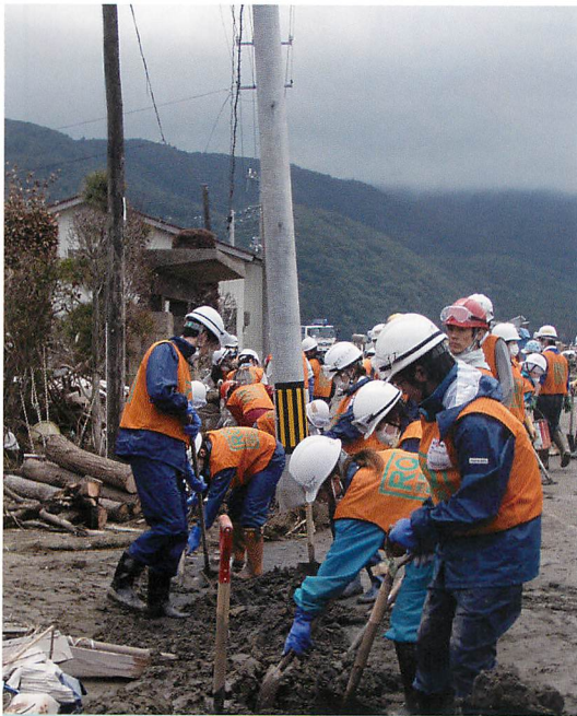
地震前の道に復旧させるために、道路に積みもって固くなった砂利と泥の除去作業。重機を入れるためには、まず人の力で道をつくる。ほかのボランティア団体の方々と一緒に100人近い人数での道づくり作業だった。
