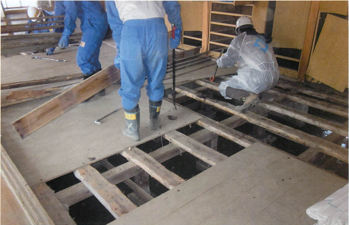
津波の被害を受けた家の床下に入り込んでしまった泥を取り除くためにバールなどを用いて床板をはがした。
