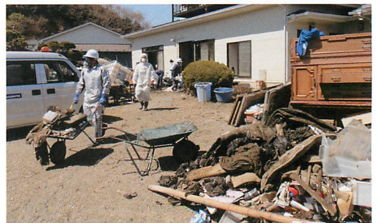
石巻市の谷地での泥だし。まず家財道具を外に出し、そして家の中の泥だしをした。
