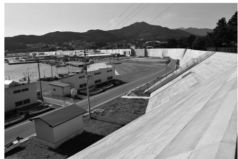
岩手県の海岸集落に建設された巨大な防波堤。内側の集落からは海の様子を見ることはできない。一方で、この巨大な防波堤の高さは津波の最大高には届いていない。
